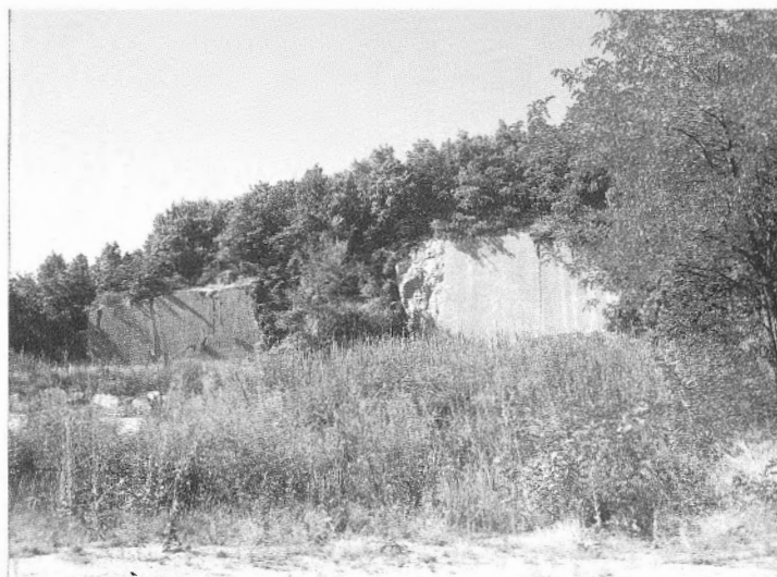
Fig. 17 – Il fronte della vecchia Cava Filo, nei Gessi Bolognesi, offre uno spaccato che bene esemplifica le caratteristiche che presiedono allo sviluppo del carsismo nei gessi messiniani. Il banco evaporitico è interessato da un numero tutto sommato ridotto di fratture subverticali, a spaziatura da metrica a decametrica, che sono state sede di più o meno attiva circolazione idrica, la quale risulta quindi concentrata lungo poche vie preferenziali di drenaggio, mentre la porzione di roccia tra una discontinuità e l'altra appare assolutamente non carsificata (foto D. Demaria).
