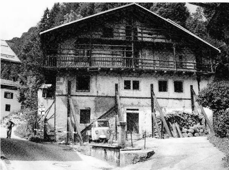
Fig. 3 – Una casa di abitazione lesionata in seguito a cedimento del suolo per processi di soluzione dei sottostanti gessi a Andrich, Agordino.
