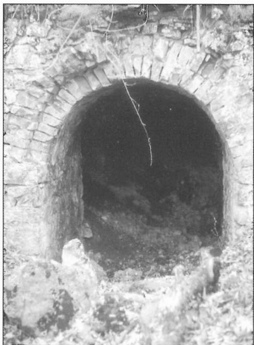
Vecchia galleria di miniera a Montecreto.
