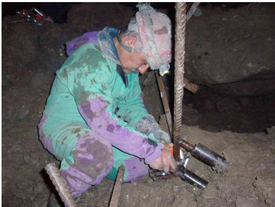
2008: Baldo costruisce il telaio che consente la riapertura del passaggio al di sotto della frana, nella Risorgente del Rio Basino.
