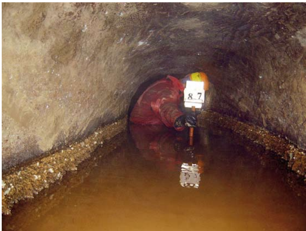
Il rilievo in un tratto allagato dell'Acquedotto Romano.
