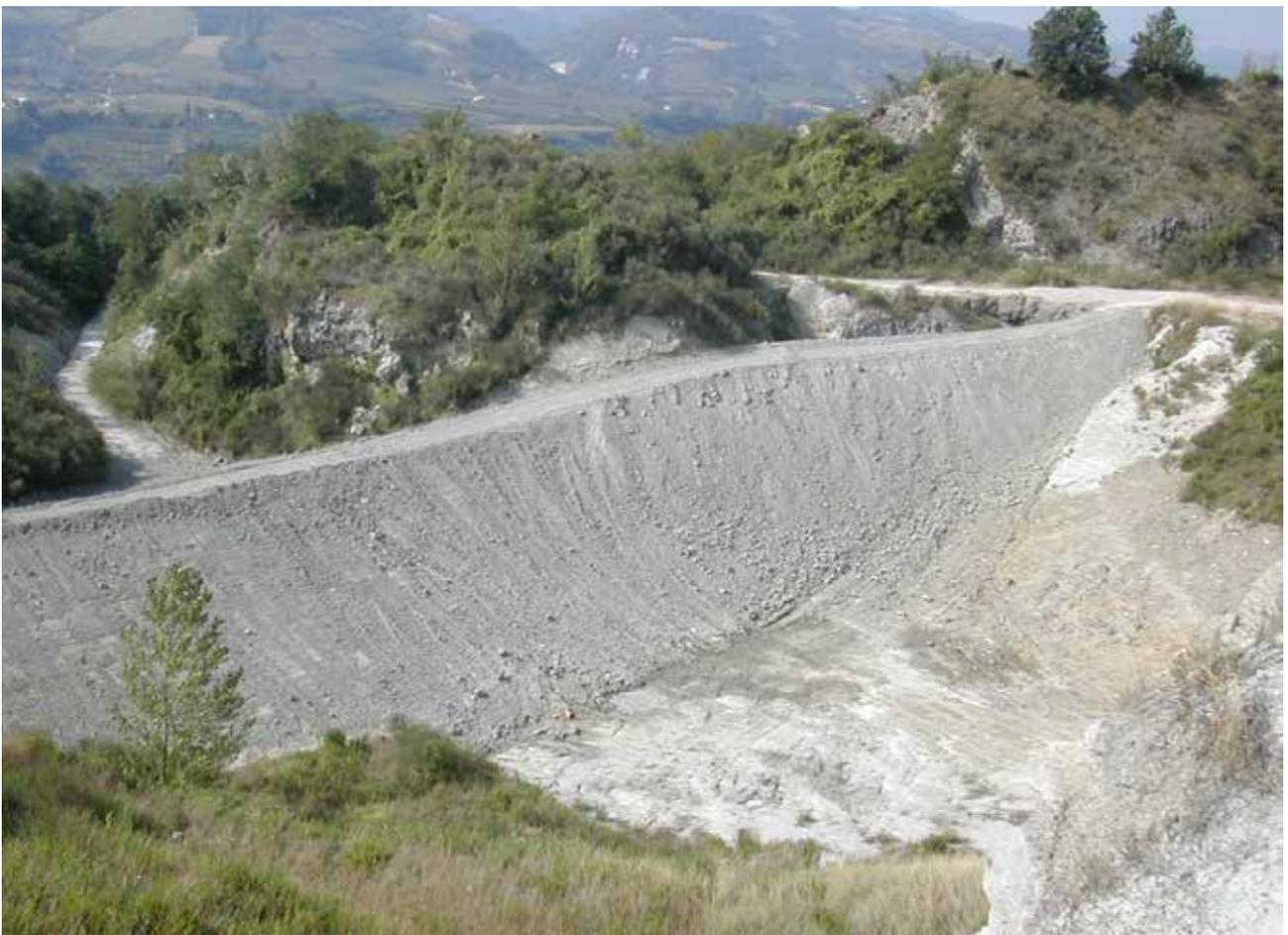
Figg. 14-15 – Edificazione dell'imponente terrapieno che permette di raggiungere in sicurezza anche il settore occidentale della cava (foto Archivio Consorzio di Bonifica della Romagna Occidentale).
