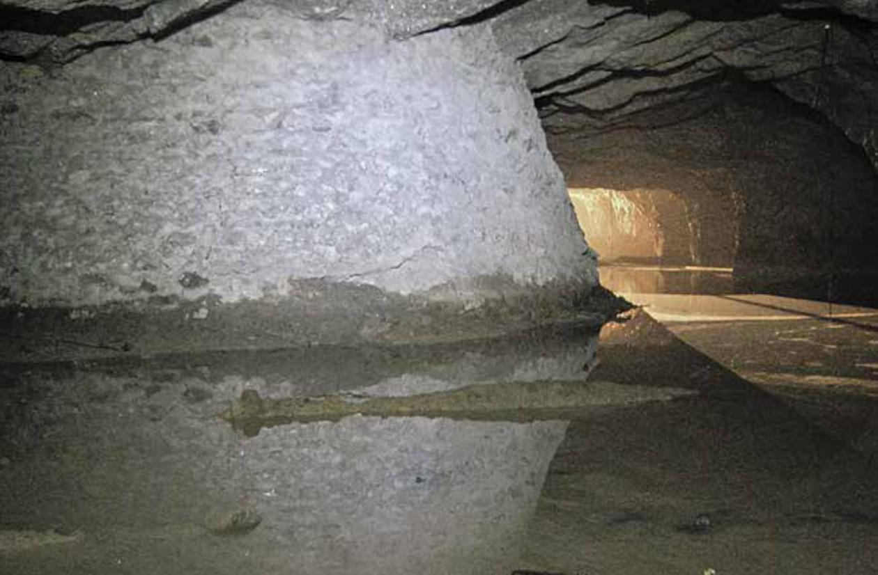
*Muro di ripiena costruito attorno al pilastro di gesso del livello inferiore delle gallerie della ex cava Prete Santo, con blocchi di gesso e malta cementizia, quando fu riconosciuto che le lesioni riscontrate nell'edificio di civile abitazione soprastante erano ascrivibili al suo cedimento (Foto Massimo Dondi).*
