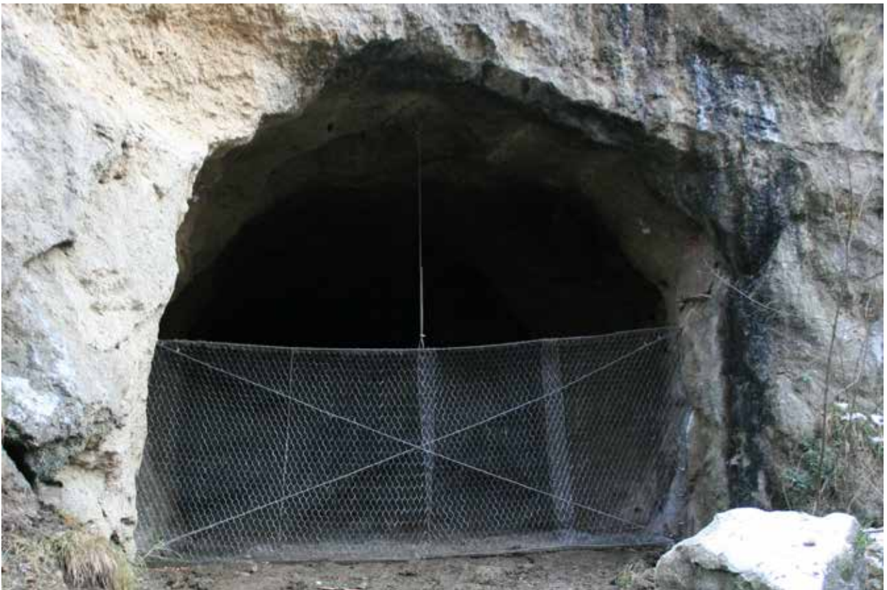
Fig. 5 – Nuova struttura di chiusura delle gallerie dell'ex cava SPES, realizzata con il Progetto Life "Gypsum" (foto M. Bertozzi).
