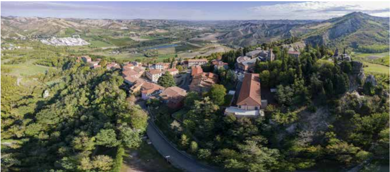
Fig. 37 – Veduta odierna della sommità della rupe gessosa di Tossignano: contrariamente a quanto previsto dal piano di ricostruzione post-bellico dell'abitato, l'area non venne completamente adibita a verde pubblico, bensì vide sorgere nel corso dei decenni vaste edificazioni, dalla casa di riposo (visibile in primo piano) a strutture collegate alla chiesa di S. Michele (sullo sfondo a destra) (foto P. Lucci). Lo stesso boschetto sommitale a suo tempo impiantato, posto tra la casa di riposo e i ruderi del castello e composto da conifere esotiche, meriterebbe oggi interventi di rinaturalizzazione simili a quelli intrapresi a Monte Rontana dal Parco regionale della Vena del Gesso Romagnola (COSTA, PIASTRA 2015).
