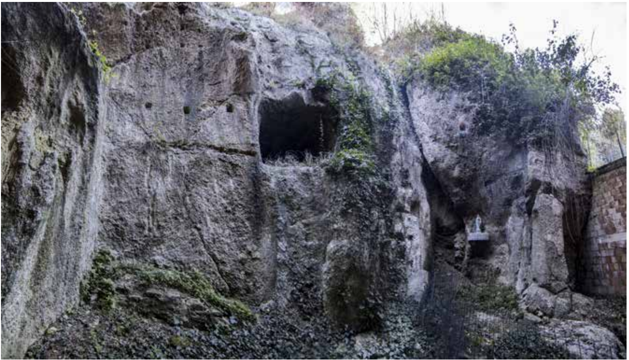
Fig. 15 – Retro dell’abitazione sorta in via Nuova 7 a Tossignano tra 1999 e primi anni 2000, in un vuoto urbanistico legato a distruzioni della II Guerra Mondiale sino ad allora mai riedificato. La parete gessosa è stata rettificata verosimilmente in età medievale; sulla sinistra è visibile uno scasso regolare quadrangolare, che ospitava una cisterna privata (cf. fig. 18), poi demolita nel contesto della recente costruzione della casa sopra menzionata. In parete si nota la Cavità artificiale I di Tossignano (CA ER BO 216), probabile cantina o annesso di età medievale dell’abitazione originaria qui presente, oggi posta a mezza altezza, ma in origine più facilmente accessibile (cf. la situazione di fig. 18, pre-rimaneggiamento recente dell’area) (foto P. Lucci).
