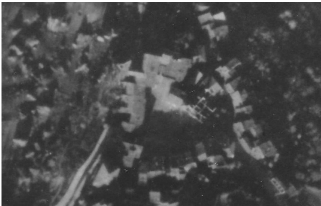
Fig. 31 – ARCHIVIO LUCIANO BENTINI (ora presso il Parco regionale della Vena del Gesso Romagnola). Particolare di un'aerofotografia RAF di Tossignano datata 2 dicembre 1944: l'immagine mostra un Palazzo del Pretorio già diruto e privo di tetto (esso iniziò ad essere colpito già nel settembre di quell'anno); il resto del nucleo storico dell'abitato risulta invece ancora relativamente ben conservato, poiché fu soprattutto il bombardamento aereo alleato del 16 dicembre 1944 (a cui probabilmente la stessa aerofotografia RAF fu propedeutica) ad atterrare irrimediabilmente gran parte dell'edificato.
