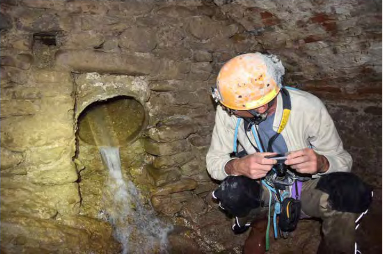
Fig. 4 – Cattura acque che defluiscono dal fondo della grotta (punto 5 della fig. 2) (foto S. Zauli).
