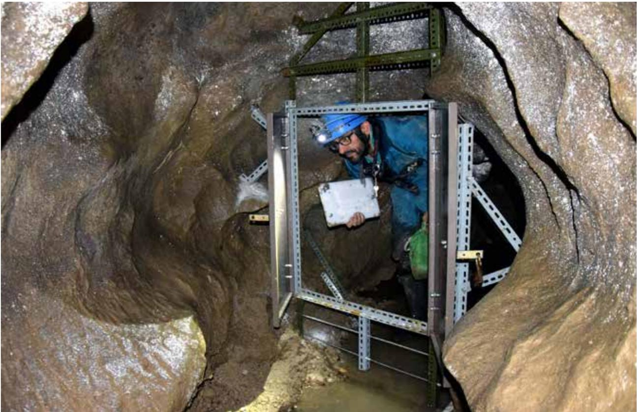
Fig. 14 – Cannello installato presso l'apporto in sinistra idrografica a protezione della stazione di misura (foto E. Sfrisi).
