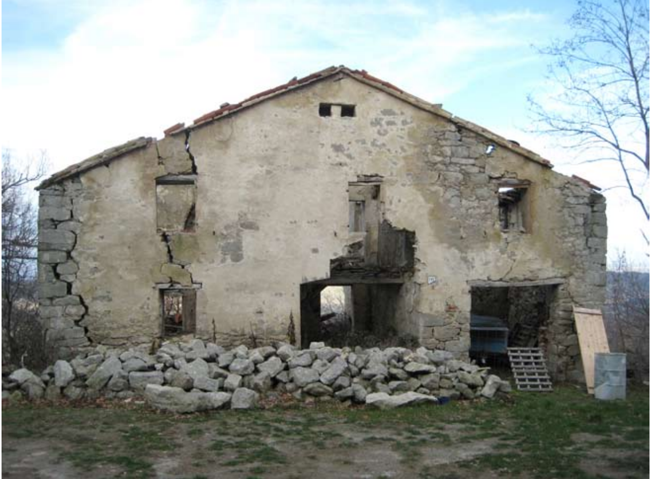
Fig. 7 - Ca' Faggia nel dicembre 2008. L'edificio, tra i più significativi dell'edilizia rurale della Vena del Gesso, era caratterizzato dall'uso esclusivo di gesso come materiale da costruzione e, una volta cotto e macinato, come legante nelle murature e come intonaco esterno; i solai, le travature e gli architravi erano lignei.
