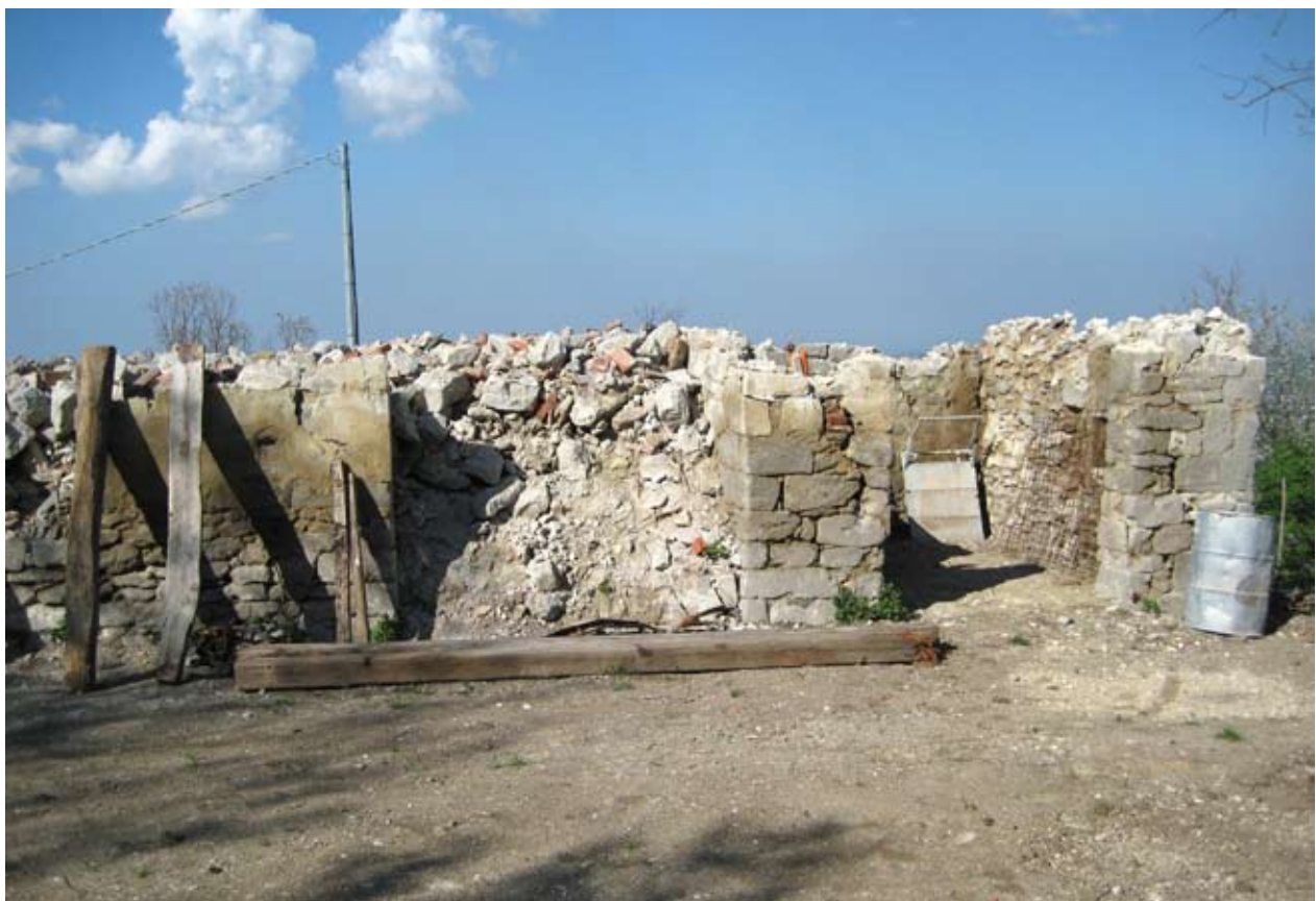
Fig. 8 - Ciò che restava di Ca' Faggia nell'aprile 2009. Nonostante la casa rurale si trovasse all'interno della Zona B del Parco Regionale della Vena del Gesso Romagnola, essa è stata inopinatamente demolita.
