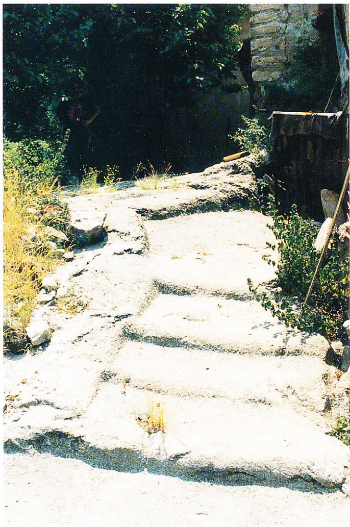
Fig. 17 - Scalinata intagliata nel substrato gessoso nell’abitato dei Crivellari. (foto S. Raccagni)
