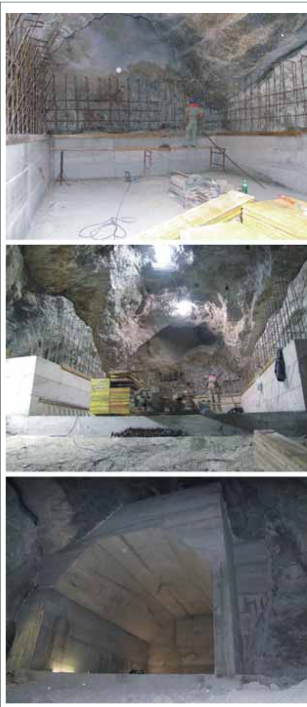
Fig. 27 – Messa in sicurezza del piano di calpestio della Grotta del Re Tiberio. In alto e al centro: fase di realizzazione della centinatura. In basso: opera terminata (foto R. Margutti).
