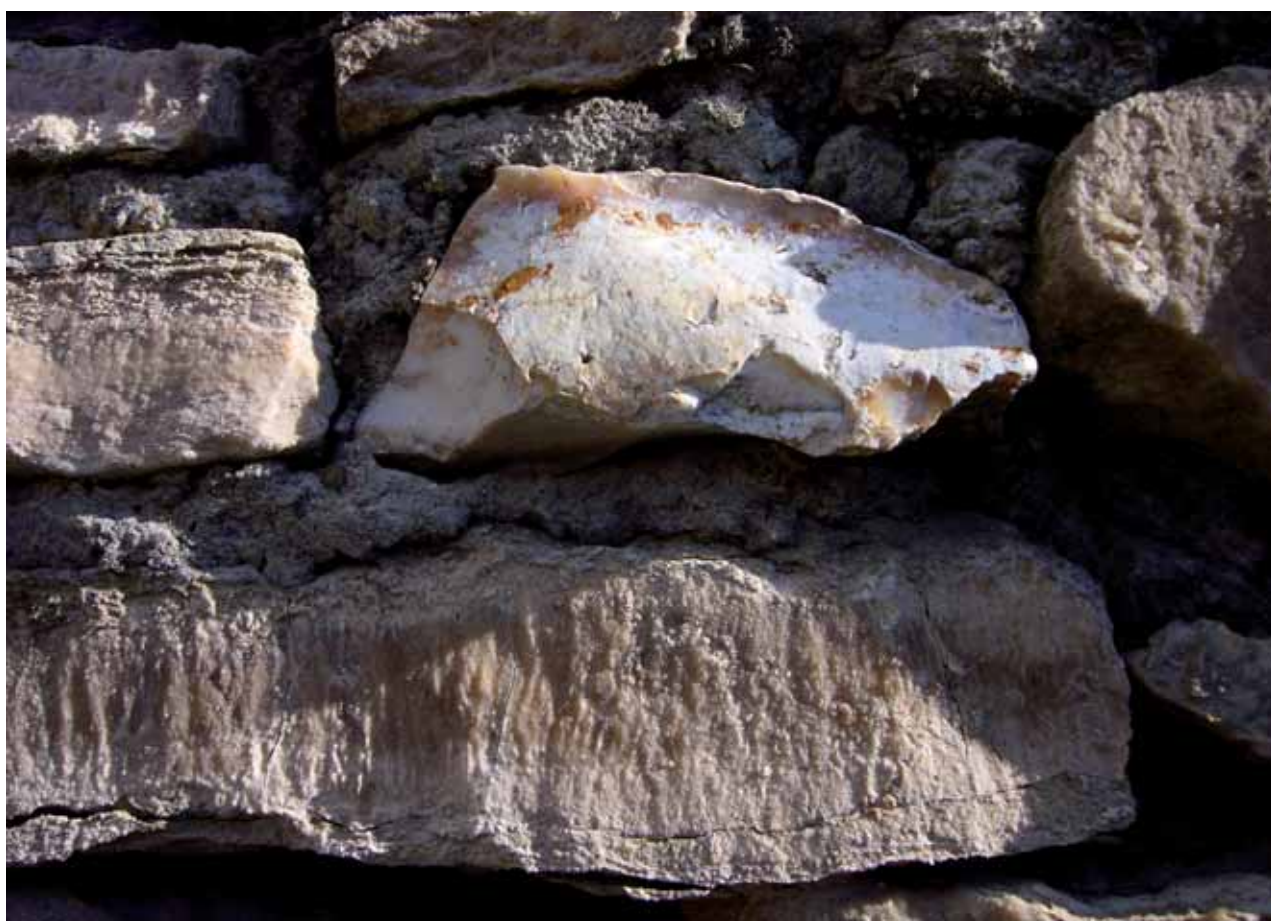
Fig. 1 – I Crivellari (Riolo Terme): particolare del muro di un vecchio edificio in blocchi di gessarenite e selce locale (foto M. Sami).
