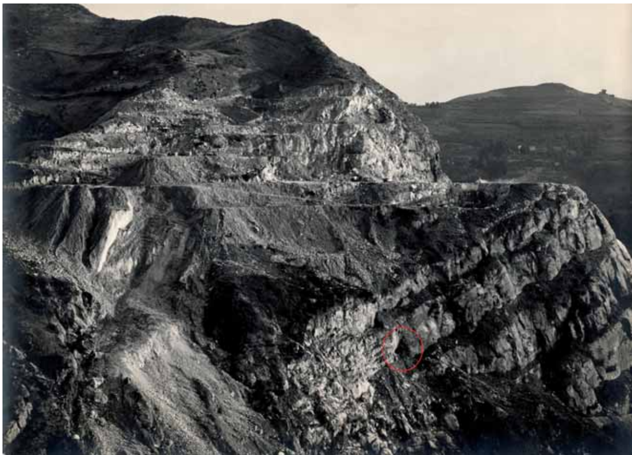
Fig. 10 – Nell’agosto 1959 la parte superiore della parete è stata demolita per far posto ad una strada di servizio, la parte sottostante è parzialmente interessata dalla discarica di materiale di riporto (foto Archivio A. Olivier). Nella foto, l’ingresso della Grotta del Re Tiberio è evidenziato con un cerchio rosso.
