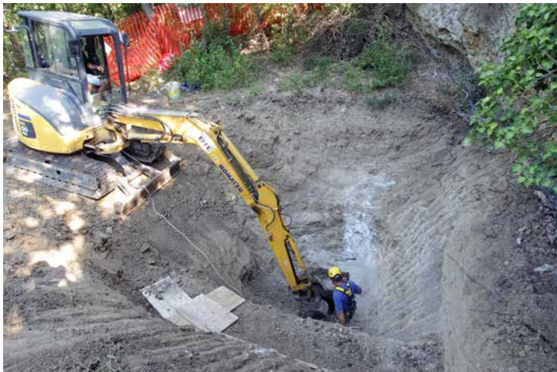
Grotta delle Pisoliti: fasi di scavo per la sostituzione del manufatto di protezione, realizzato nel 1971 ad opera dell'USB (Gessi Bolognesi).
