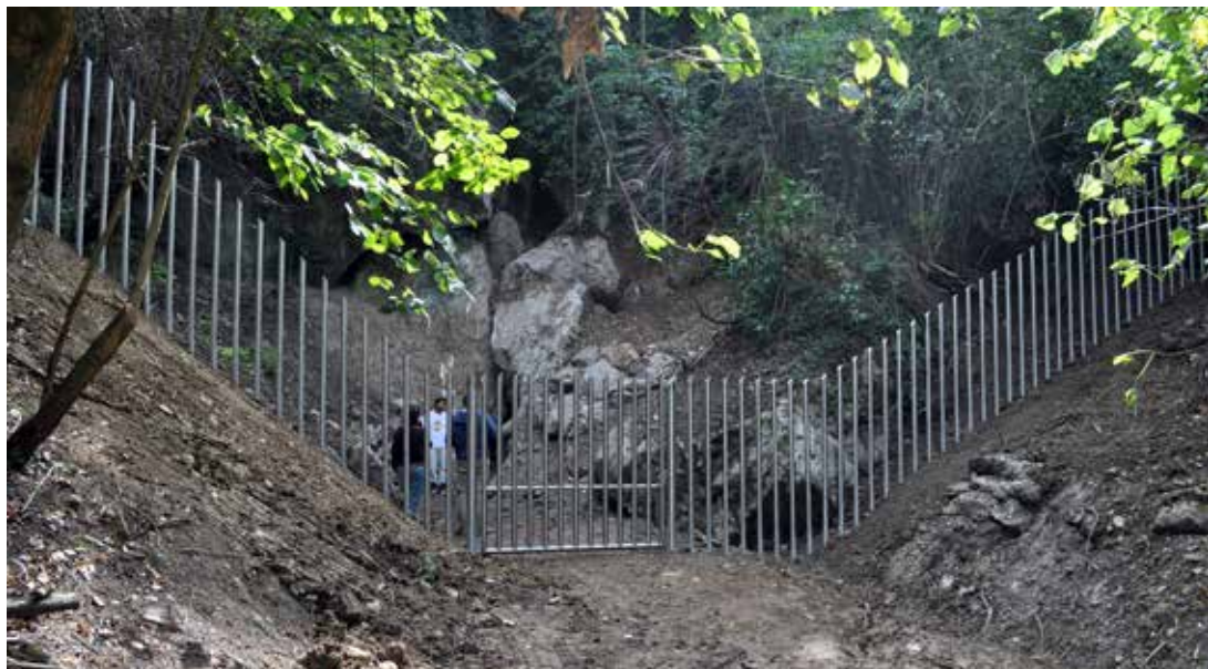
La palizzata realizzata presso l'ingresso della Grotta Siberia, nei Gessi Bolognesi, dopo i lavori di ripristino della grande frana che ne occludeva l'accesso.
