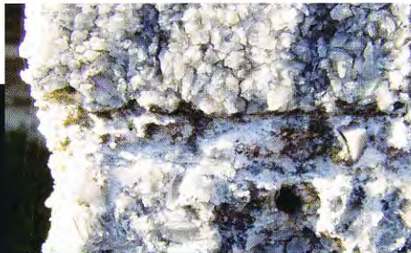
Particolare delle murature di una casa rurale della Vena del Gesso: il materiale da costruzione usato è il gesso in blocchi; il legante impiegato consiste in gesso cotto (foto S. Piastra).
