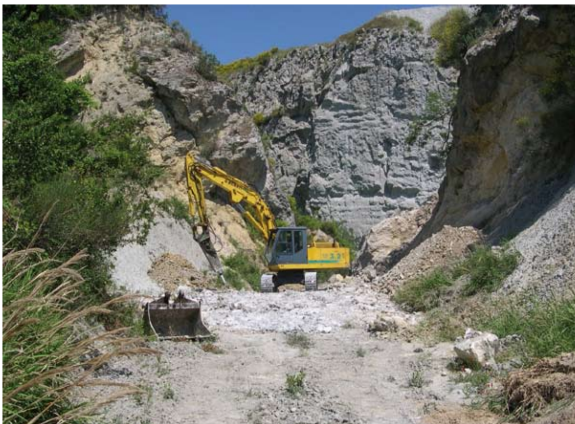
Fig. 2 – Anno 2005: una fase dei lavori di sistemazione dell'ex cava (foto G. Minardi).
