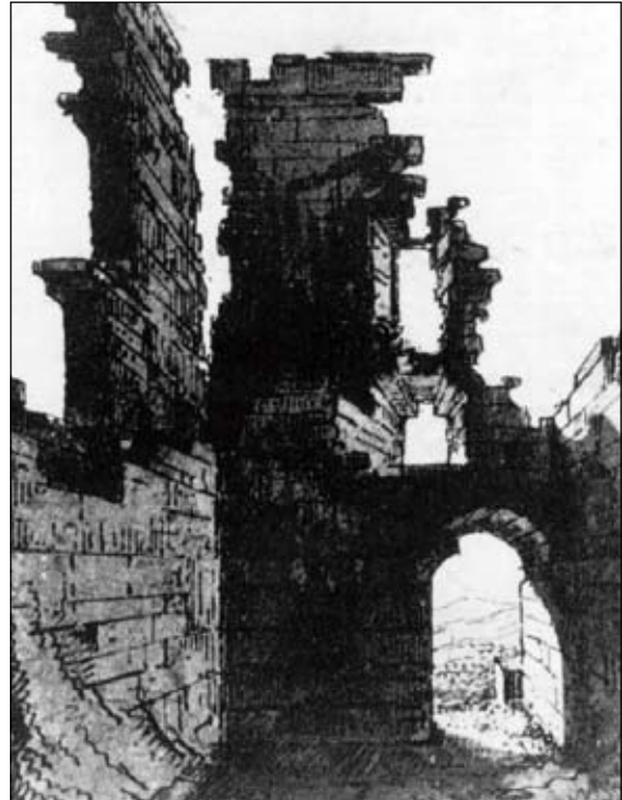
Fig. 8 – Interno del mastio della rocca di Monte Mauro in un acquerello di Romolo Liverani risalente alla metà del XIX secolo (da AA.Vv. 1974).
