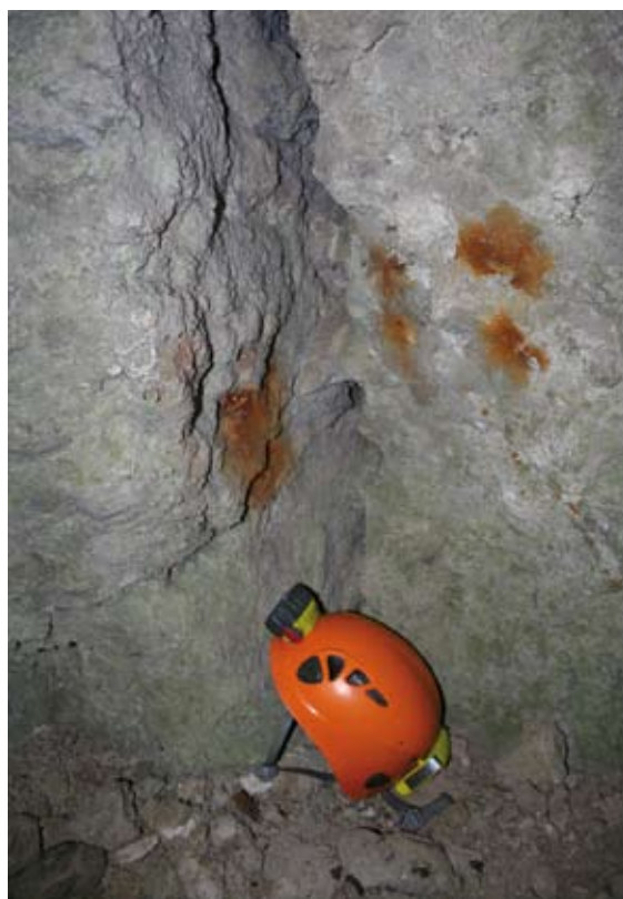
Fig. 16 – “Grotta dei chiodi”. Le macchie di ruggine visibili nell'immagine sono ricollegabili all'ossidazione di chiodi piantati in parete (foto Archivio Gruppo Speleologico Faentino).
