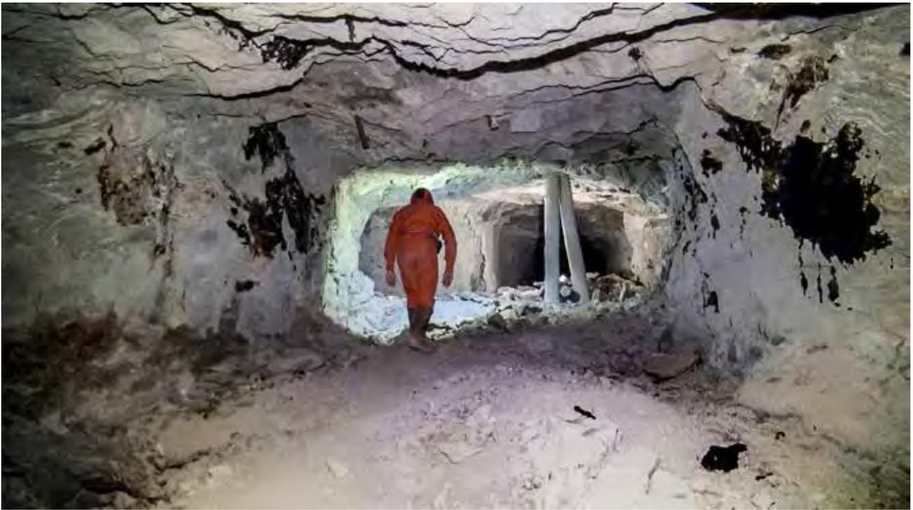
Fig. 5 – Colate di bitume dalle pareti delle gallerie (fotogramma video M.L. Garberi).
