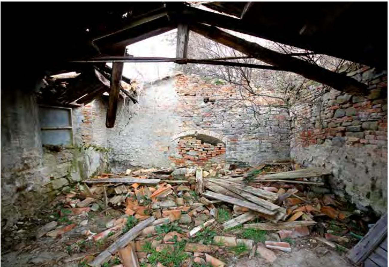
Fig. 5 – Miniera di S. Apollinare: all'interno di un edificio di servizio, è ancora individuabile l'imboccatura della discenderia, oggi murata (foto P. Lucci). Tentativi di disostruzione hanno dato esito negativo.
