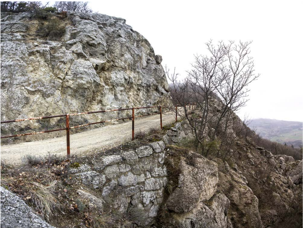
Fig. 16 – Taglio nel substrato evaporitico, funzionale a ospitare la sede stradale che conduce a Monte Mauro, e muri di sostruzione, realizzati nell'ambito dei "cantieri Fanfani" fra tardi anni Quaranta e anni Cinquanta del Novecento (foto P. Lucci).
