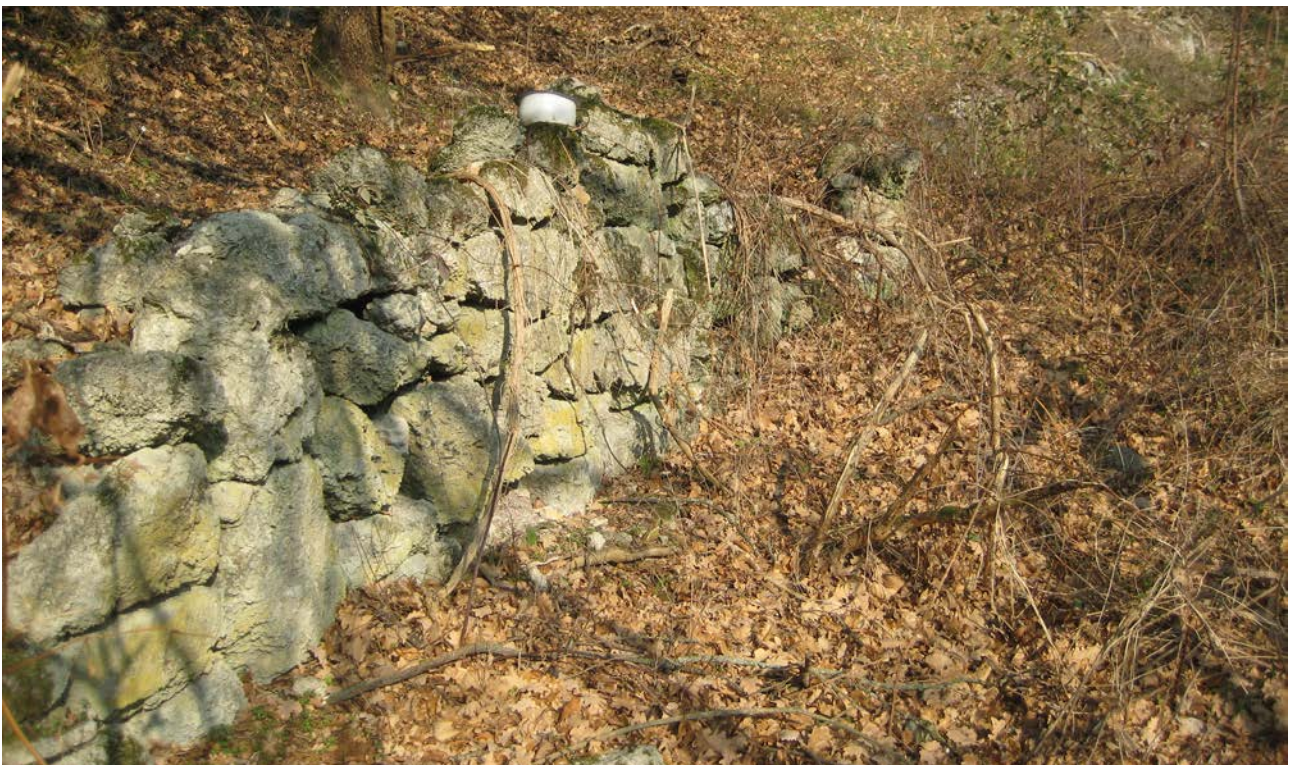
Fig. 8 – Versante nord di Monte Mauro, dolina sotto Ca' Castellina. Muretto a secco creato riutilizzando i blocchi di gesso derivanti dall'operazione di spietramento del campo, al fine di creare una sorta di terrazzamento interno alla dolina (foto S. Piastra).
