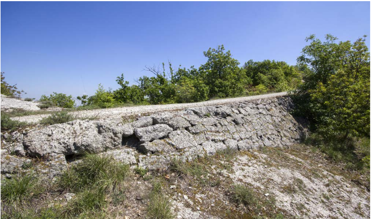
Fig. 17 – Monte Mauro. Muro di sostruzione della massicciata stradale, realizzato nel contesto dei “cantieri Fanfani”. Anni Quaranta-Cinquanta del Novecento (foto P. Lucci).
