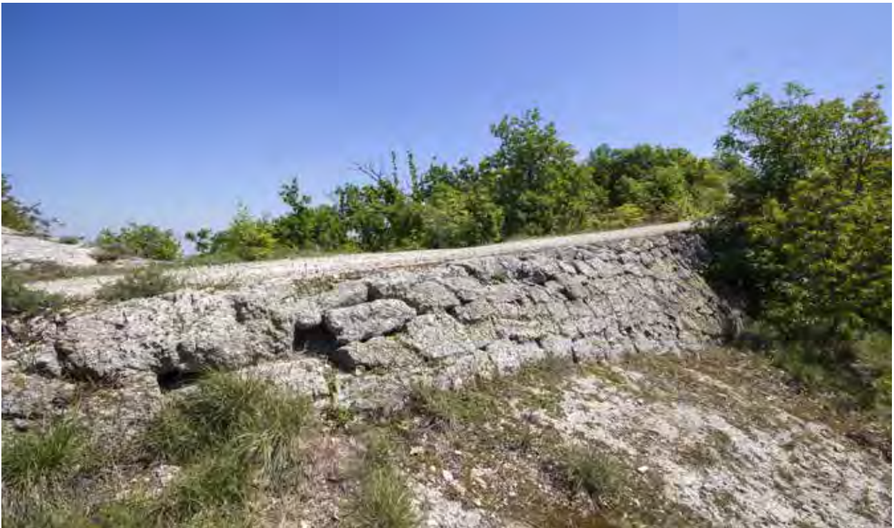
Fig. 17 – Monte Mauro. Muro di sostruzione della massiciata stradale, realizzato nel contesto dei “cantieri Fanfani”. Anni Quaranta-Cinquanta del Novecento (foto P. Lucci).
