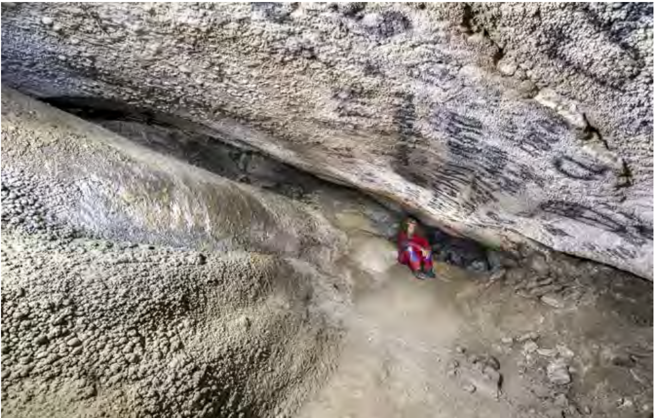
Fig. 37 – Grotta dei Banditi. Condotta fossile in parte occupata da riempimenti e la cui volta, deturpata da scritte in nerofumo, è interessata da diffuso concrezionamento di gesso microcristallino (foto P. Lucci).
