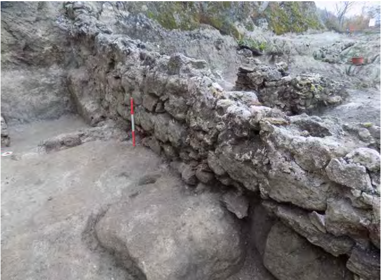
Fig. 18 – Ca' Castellina. Particolare di USM 9: si notino le tracce di intonaco ancora applicato alla parete (foto S. D'Amato).
