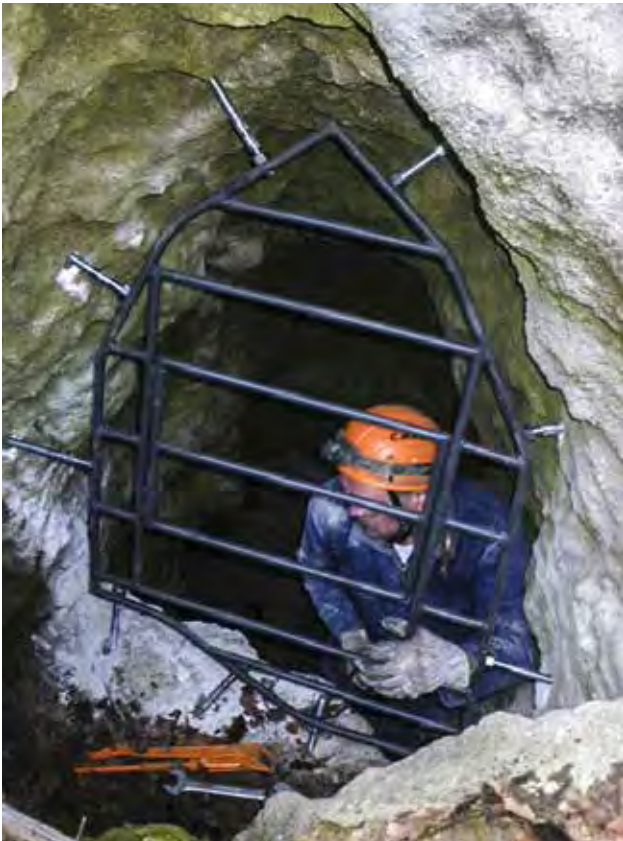
Fig. 11 – Messa in opera del cancello a protezione della Grotta III di Ca' Boschetti (foto Archivio GSE MO).
