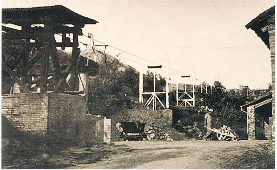
Fig. 22 – Brisighella, impianto del "Molinone": stazione d'arrivo della teleferica per il trasporto del minerale gessoso dalla cava del Monticino in un'immagine della fine degli anni 1950 (foto Archivio famiglia Zerbato – Brisighella).
