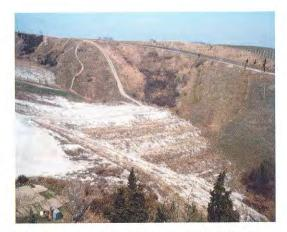
Fig. 18 – Fianco occidentale della Valle Cieca con traccia di gradonature argillose di stabilizzazione delle colate innescate dai versanti calanchivi, in alto a sinistra (foto G.B. Vai, 1989).
