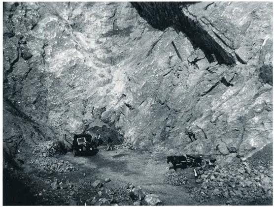
Fig. 16 – La cava del Monticino negli anni 1950, all'epoca della gestione della Gessi del Lago d'Iseo (foto Archivio famiglia Zerbato – Brisighella). Il minerale era trasportato dal piazzale della cava alla teleferica, oltre che tramite un autocarro, anche con un carro a trazione animale.
