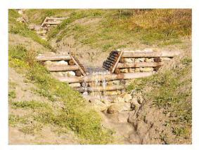
Fig. 10 – Briglia in legno di castagno e pietrame di gesso realizzato nell'impluvio principale della valle cieca (foto Archivio Consorzio di Bonifica della Romagna Occidentale).
