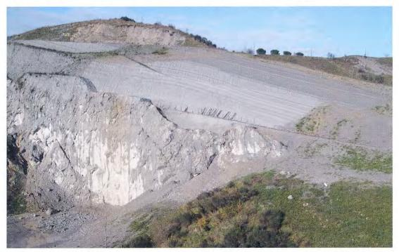
Fig. 8 – Anno 2005: panoramica dei lavori sulla sommità della parete di scavo subverticale della ex cava, con sbancamento delle Argille Azzurre, riprofilatura del versante e costruzione del sentiero didattico geologico (foto Archivio Consorzio di Bonifica della Romagna Occidentale).
