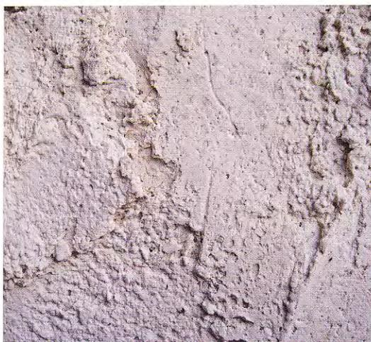
Fig. 38 – Particolare dell'intonaco in polvere di gesso, steso a spatola, di una parete interna di Ca' Castellina (foto S. Piastra).
