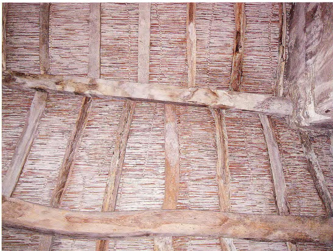
Fig. 41 – Incannacciata impastata con gesso cotto a rivestire internamente la copertura. Ca' Castellina (foto S. Piastra).
