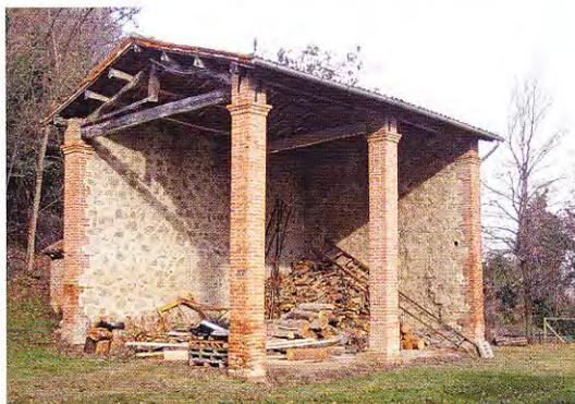
Fig. 24 – Fienile presso la chiesa parrocchiale di Rontana (Brisighella): muro posteriore in blocchi di gesso; pilastri anteriori in laterizi; copertura in coppi sorretta da capriata lignea (foto S. Piastra).
