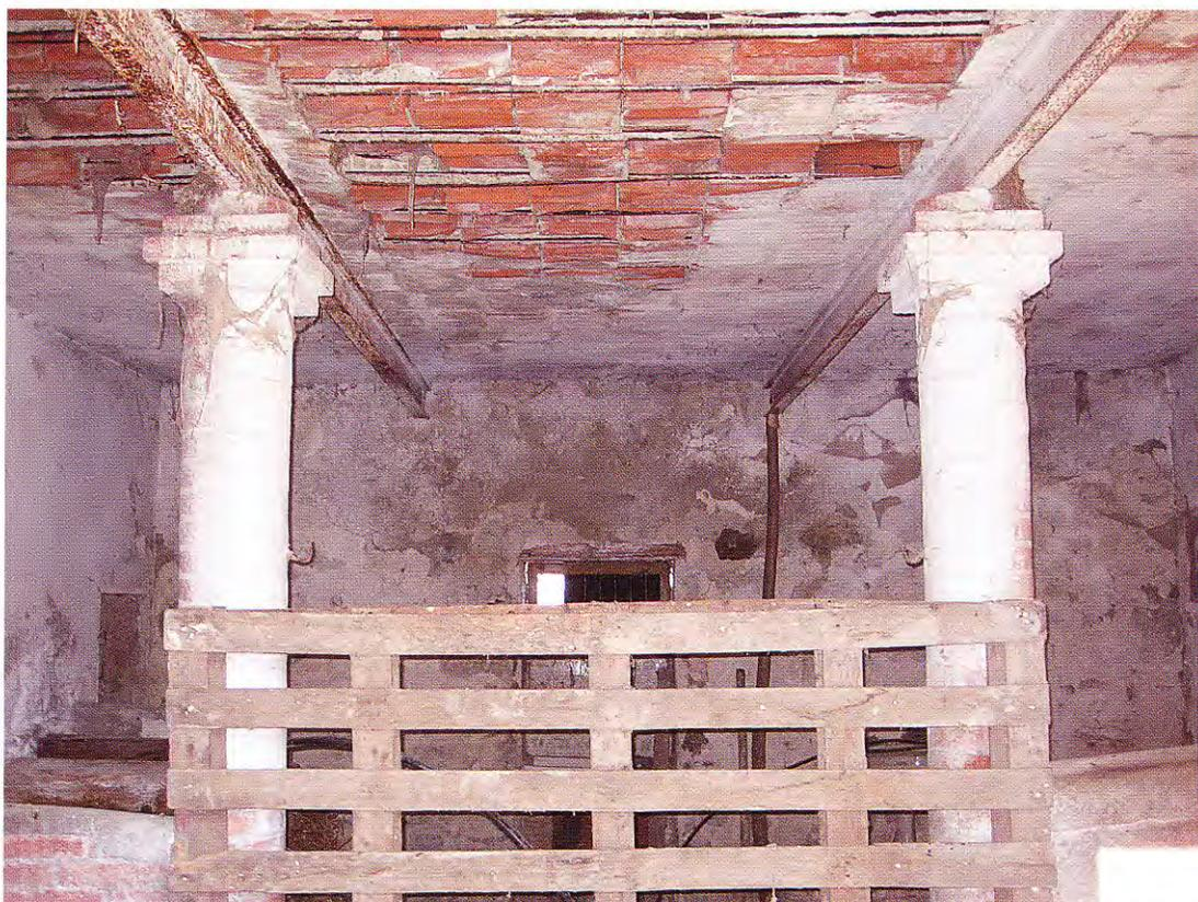
Fig. 13 – Stalla con soffitto piatto e colonnine in mattoni semicirculari in un edificio del nucleo di Ca' di Sotto (Monte Mauro) (foto S. Piastra).
