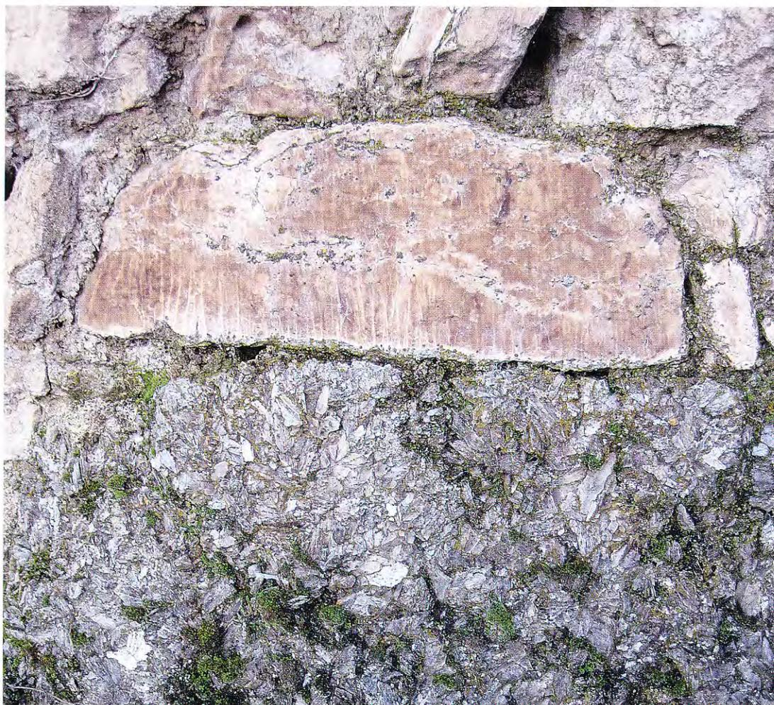
Base della muratura di un edificio di Crivellari (Riolo Terme): substrato selenitico sagomato artificialmente, su cui poggia un blocco di “gesso color miele” intaccato da *karren*. Il legante impiegato è gesso cotto (foto S. Piastra).
