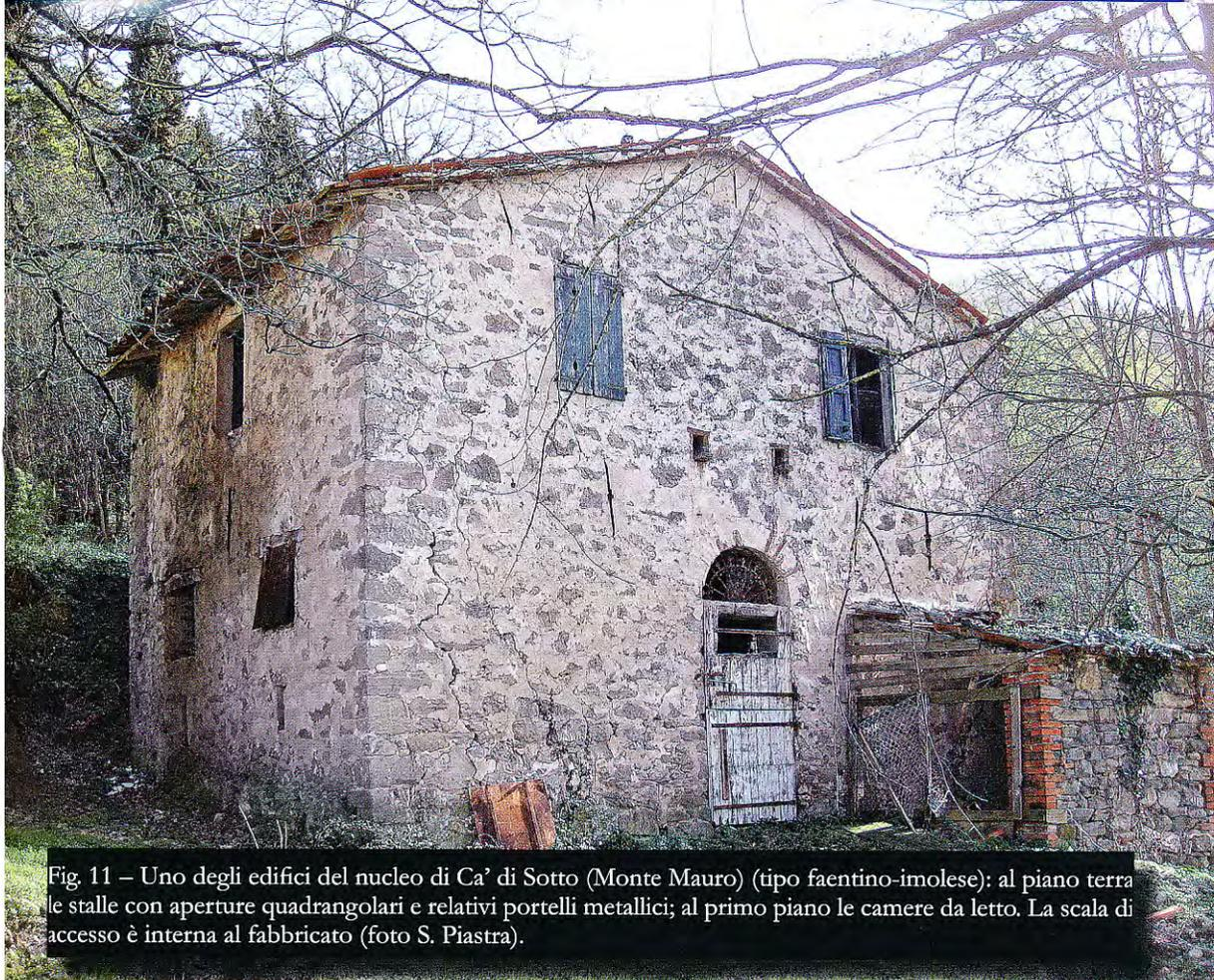
Fig. 11 – Uno degli edifici del nucleo di Ca’ di Sotto (Monte Mauro) (tipo faentino-imolese): al piano terra le stalle con aperture quadrangolari e relativi portelli metallici; al primo piano le camere da letto. La scala di accesso è interna al fabbricato (foto S. Piastra).
