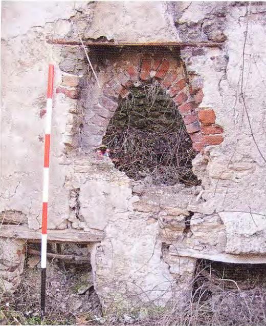
Fig. 26 – Forno posto esternamente all'abitazione. Crivellari (Riolo Terme) (foto S. Piastra).
