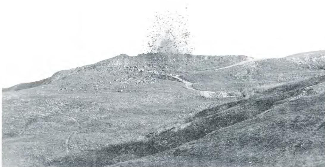
Fig. 2 – Lavori di rimodellamento delle pendici calanchive tramite esplosivi nell’ambito della “Bonifica Integrale”. Rio Bo (Brisighella) Anni ’30 del Novecento. Archivio Consorzio di Bonifica della Romagna Occidentale (da PIASTRA 2005a).
