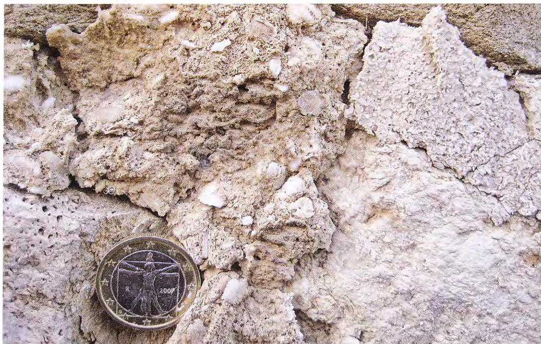
Fig. 37 – Particolare di una muratura della chiesa di Rontana (Brisighella): il legante utilizzato è il gesso da presa, macinato in maniera grossolana e cotto a basse temperature (foto S. Piastra).
