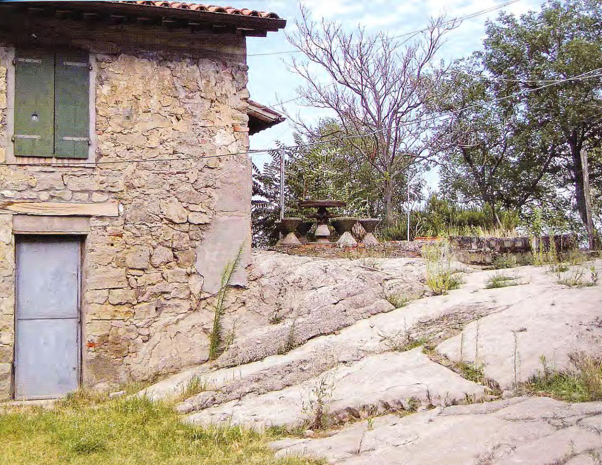
Fig. 27 – Casa presso Varnello (Brisighella), poggiante direttamente su substrato gessoso (foto S. Piastra).
