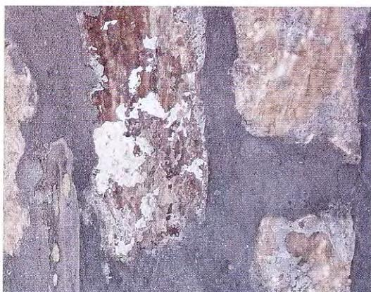
Fig. 31 – Blocchi di “gesso color miele” in opera. Crivellari (foto S. Piastra). La stuccatura tra blocco e blocco, in cemento, non è appropriata.
