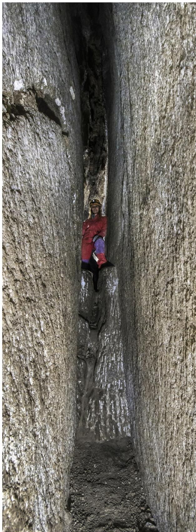
Fig. 29 – Grotta della Lucerna. Corridoio con pareti finemente scalpellate. Il tratto verticale al centro della foto, subito sotto la speleologa, ha incise alcune pedarole. Questo ambiente, completamente artificiale, consisteva inizialmente in una fessura tamponata da argilla con inclusioni di *lapis specularis* (foto P. Lucci).
